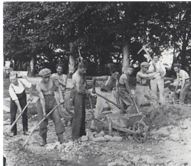
Beginn zum Bau des Stadions Rankhof.
