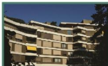
Mehrfamilienhäuser Hirzbodenpark (Gellert) 4052 Basel
