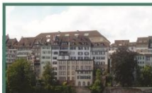
Mehrfamilienhäuser Augustinergasse 1 + 3 4051 Basel
